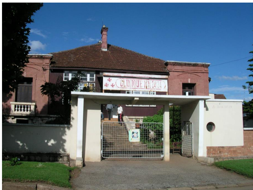
Photo 9 – L'ancienne villa Les Peupliers devenue clinique privée (novembre 2011). Malgré de nombreux changements (varangue transformée en véranda, clôture extérieure, portail d'entrée...), on reconnaît la cheminée, la toiture, les deux ailes de la façade privées de leur balustrade sommitale (cliché de l'auteur).
