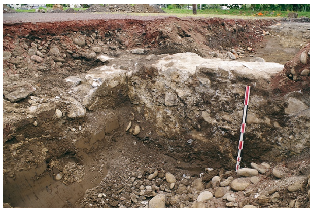
Fig. 15 : L'angle sud-est des fondations de la halle à marchandises contre lesquelles viennent s'appuyer les remblais de galets de la plateforme ferroviaire (Photo M. Baffert, Inrap)
