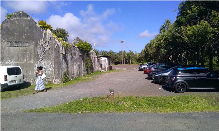
Fig. 8 : Le bâtiment voyageurs de la gare de Saint-Benoît en décembre 2020 (Photo F. Gerber, Inrap)
